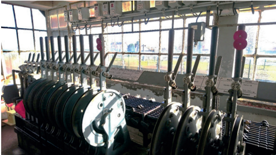
Photo 2 : Poste d'aiguillage en gare de Châteaudun (Eure-et-Loir)
